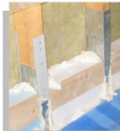
Valesokkeli korjattu termotuotteilla
