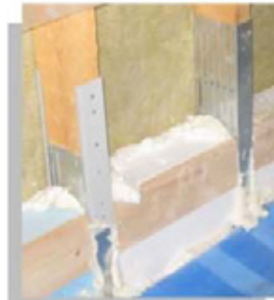
Valesokkeli korjattu termotuotteilla
