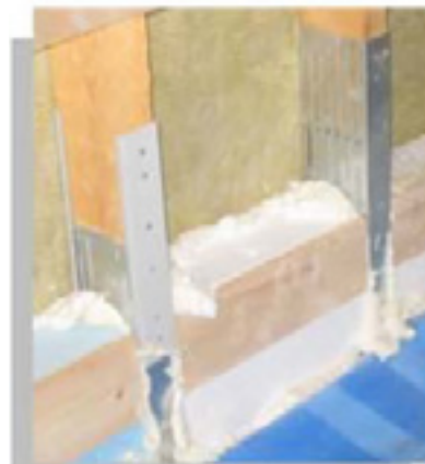
Valesokkeli korjattu termotuotteilla
