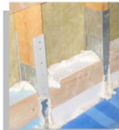
Valesokkeli korjattu termotuotteilla
