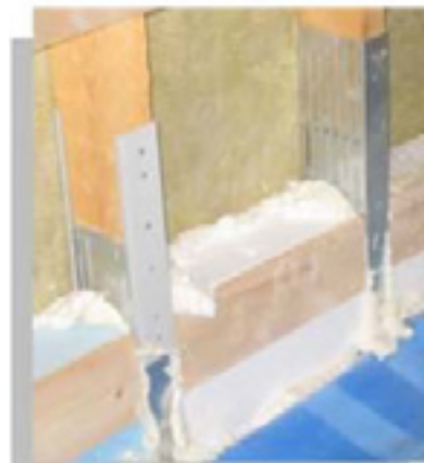
Valesokkeli korjattu termotuotteilla
